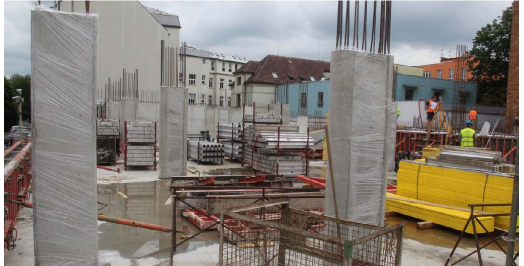
Naše reference v Českých Budějovicích: Betonáž sloupů za pomoci přísady MasterSure 900
