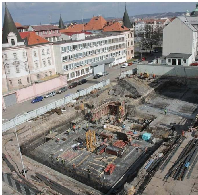
Parkovací dům České Budějovice (CZ): Betonáž sloupů za pomoci přísady MasterSure 900
