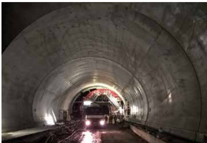
Betonáž sekundárneho ostenia
