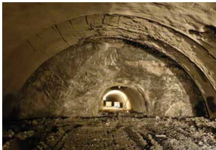
Severná tunelová rúra s prieskumnou štôľňou
