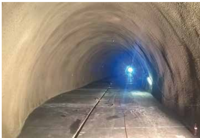
Sekundárne ostenie zo striekaného vláknobetónu
