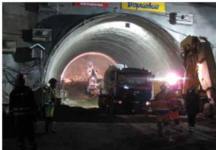
Aplikácia striekaného betónu – hlavná tunelová rúra
