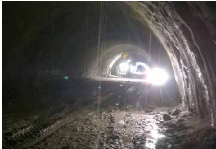
Primárne ostenie tunela – južná tunelová rúra
