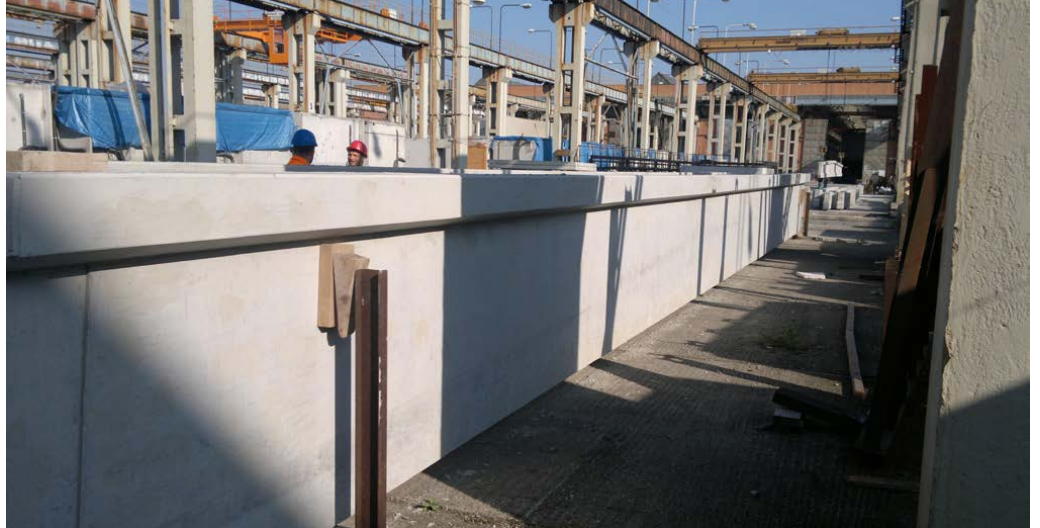
Naše reference v Praze (CZ): Předpjaté vazníky ze samozhutnitelného betonu o délce 20 m
