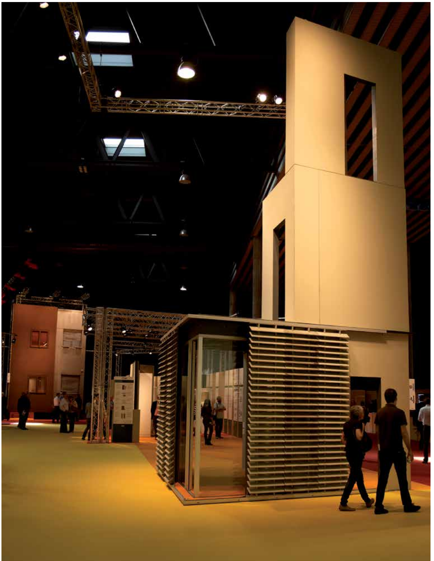
Samverkanskonstruktion av stål, tunna paneler och solskydd av högpresterande betong armerad med MasterFiber. FoU projekt utvecklat av ASCAMM\iMat – Construction Technologies.
