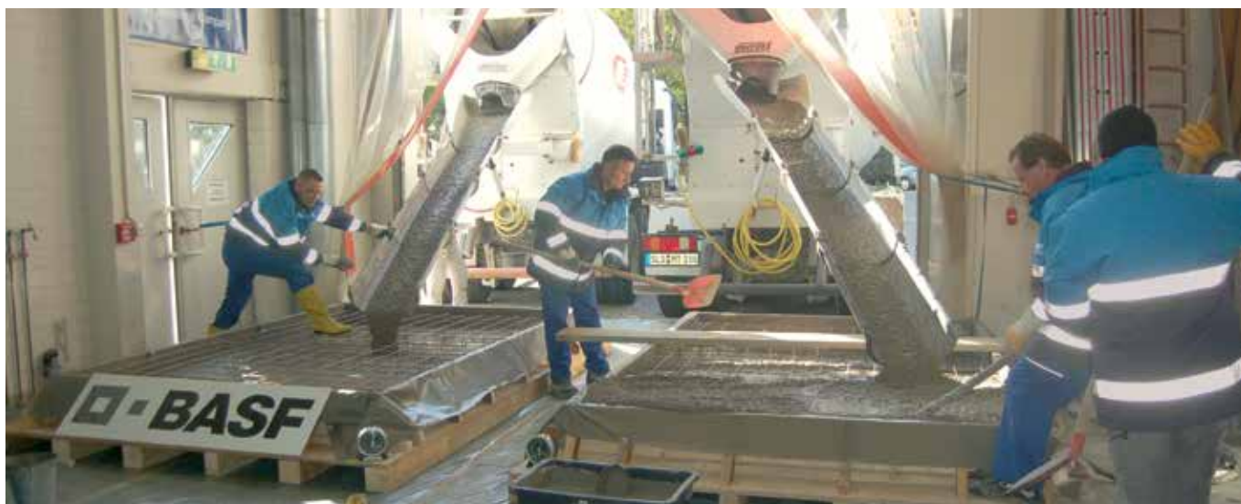
En operatör kan lägga Smart Dynamic Concrete betydligt snabbare än tre operatörer kan lägga konventionellt vibrerad betong.
