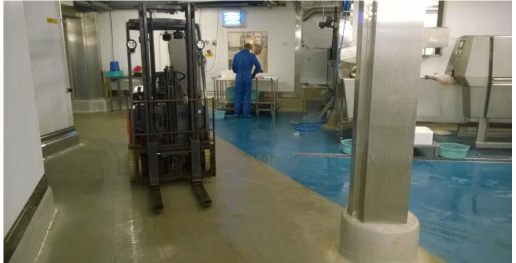
Ytbeläggning av produktionsanläggningens golv
