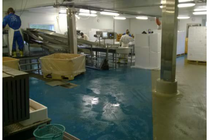
Ytbeläggning av produktionsanläggningens golv
